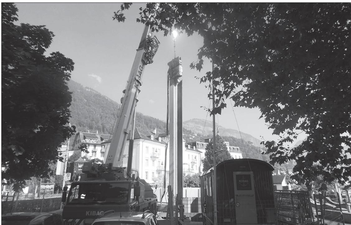
Unüberhör- und unübersehbar: Auf dem Platz neben dem Oberdorfleis werden Spundwände in den Boden getrieben.
