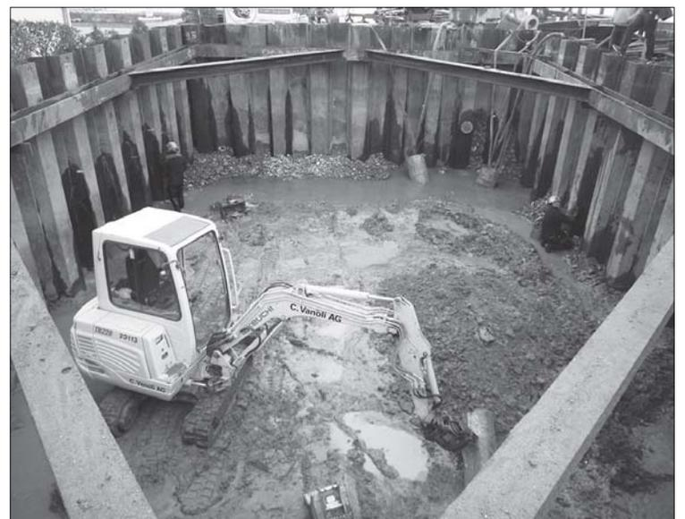
5. Dezember 2017: Bagger- und Abdichtungsarbeiten in der Baugrube.
