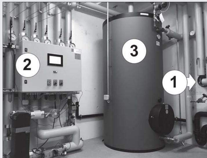
Ein Blick in den Heizraum eines Weggiser Mehrfamilienhauses, das die Energie für Brauch- und Heizungswasser durch den neuen Wärmeverbund der Korporation Weggis bekommt (links der Wärmetauscher (2), dann der Boiler (3) und ganz rechts der «Hauseingang» für die Energie (1).
