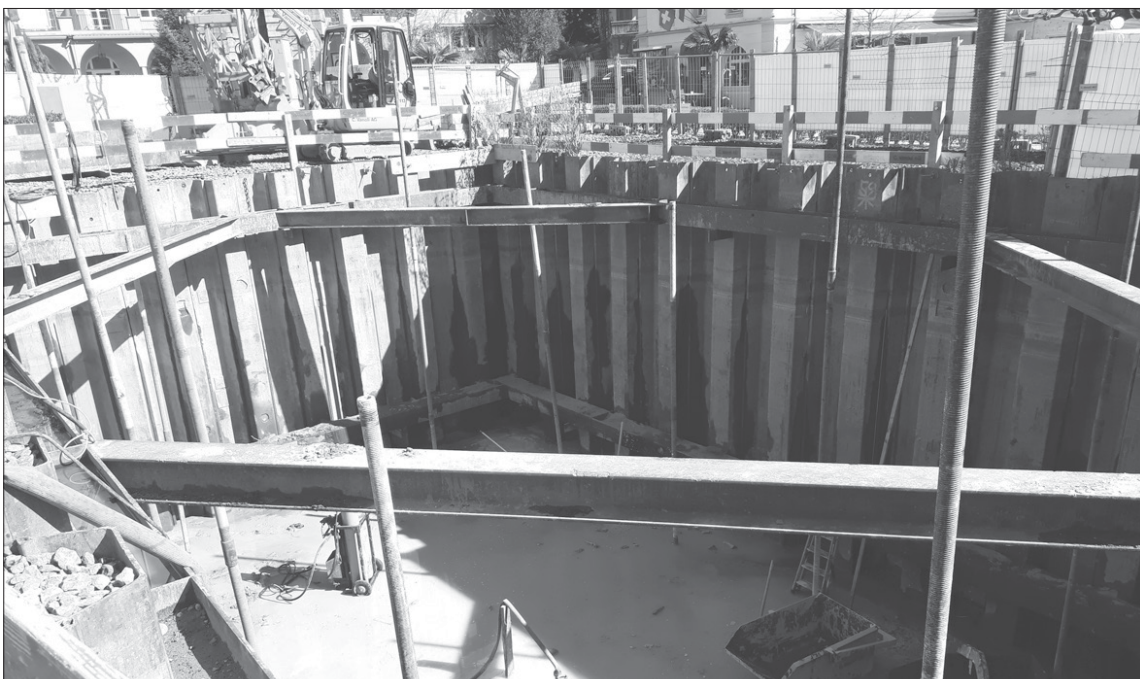
Pumpwerk-Bodenplatte betoniert.
