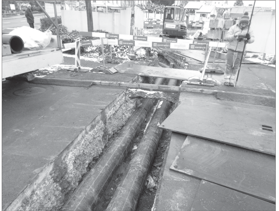
Querung Seestrasse zum Pumpwerk.
