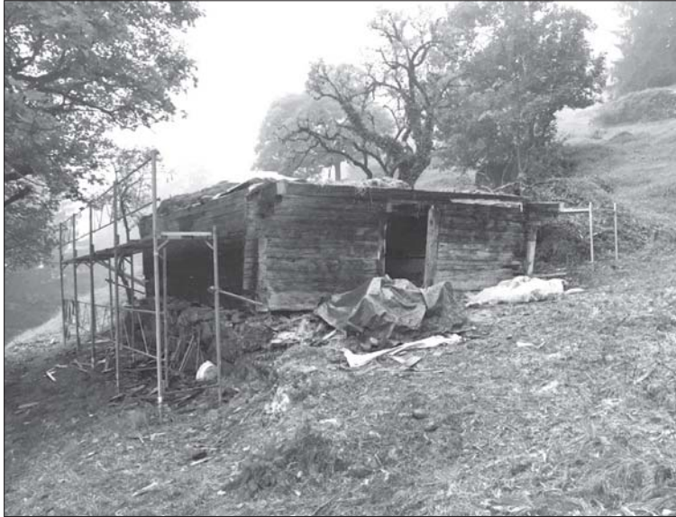
Abbrucharbeiten Alpstall Obere Buche.
