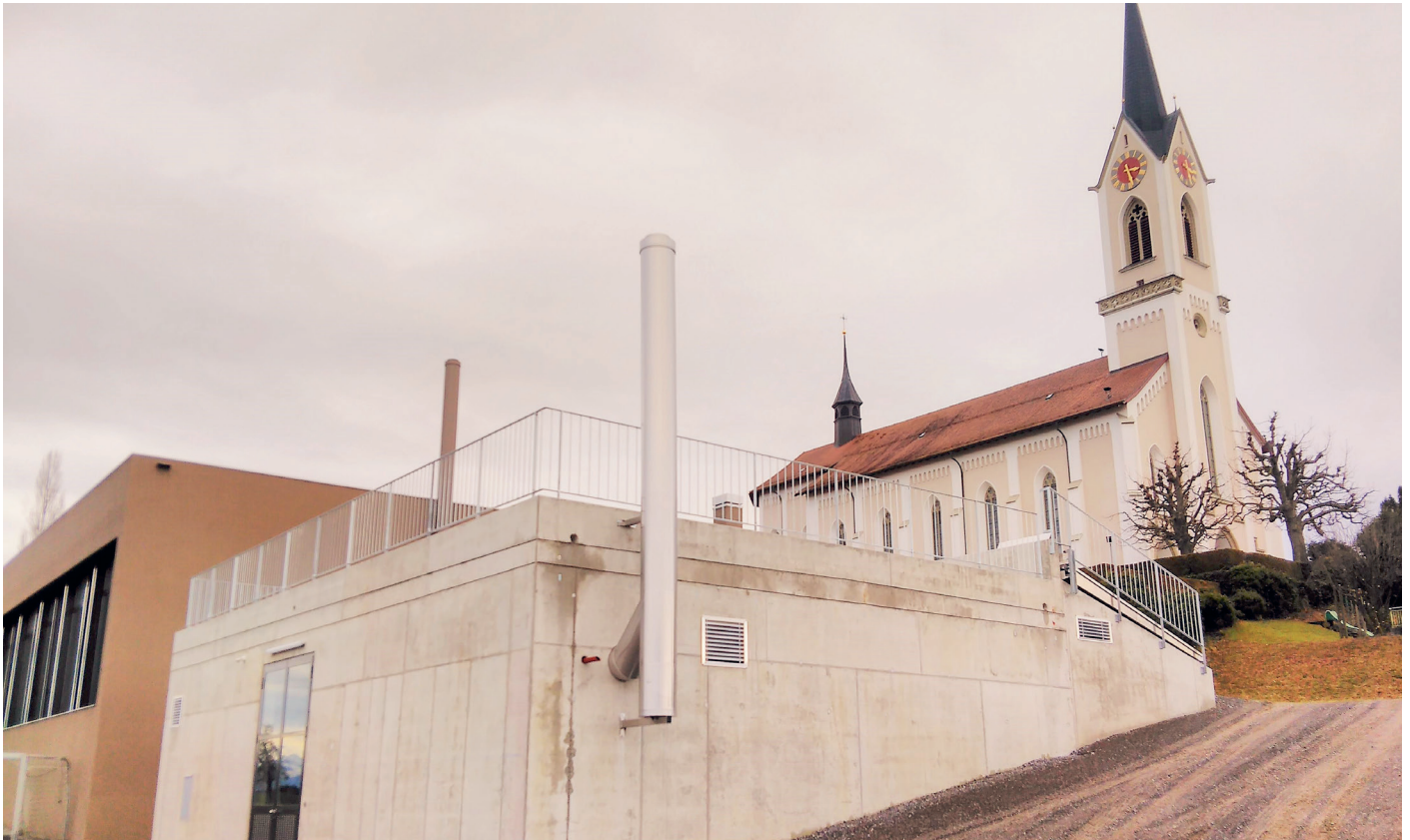
Aussenansicht der neuen Heizzentrale in Nottwil.
