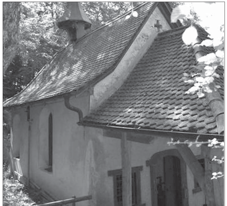
Die Heiligkreuzkapelle soll saniert werden.
