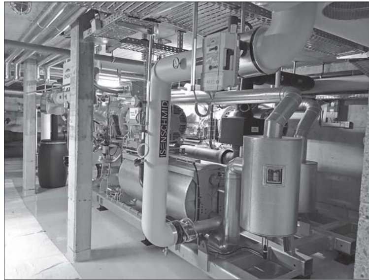
Wärmepumpe für 1 MW Wärmeleistung.
