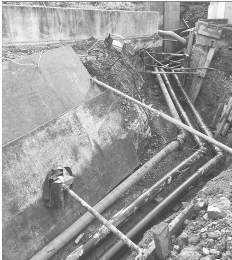
Gemeinde und Korporation: Trinkwasser- und Fernwärmeleitungen.
