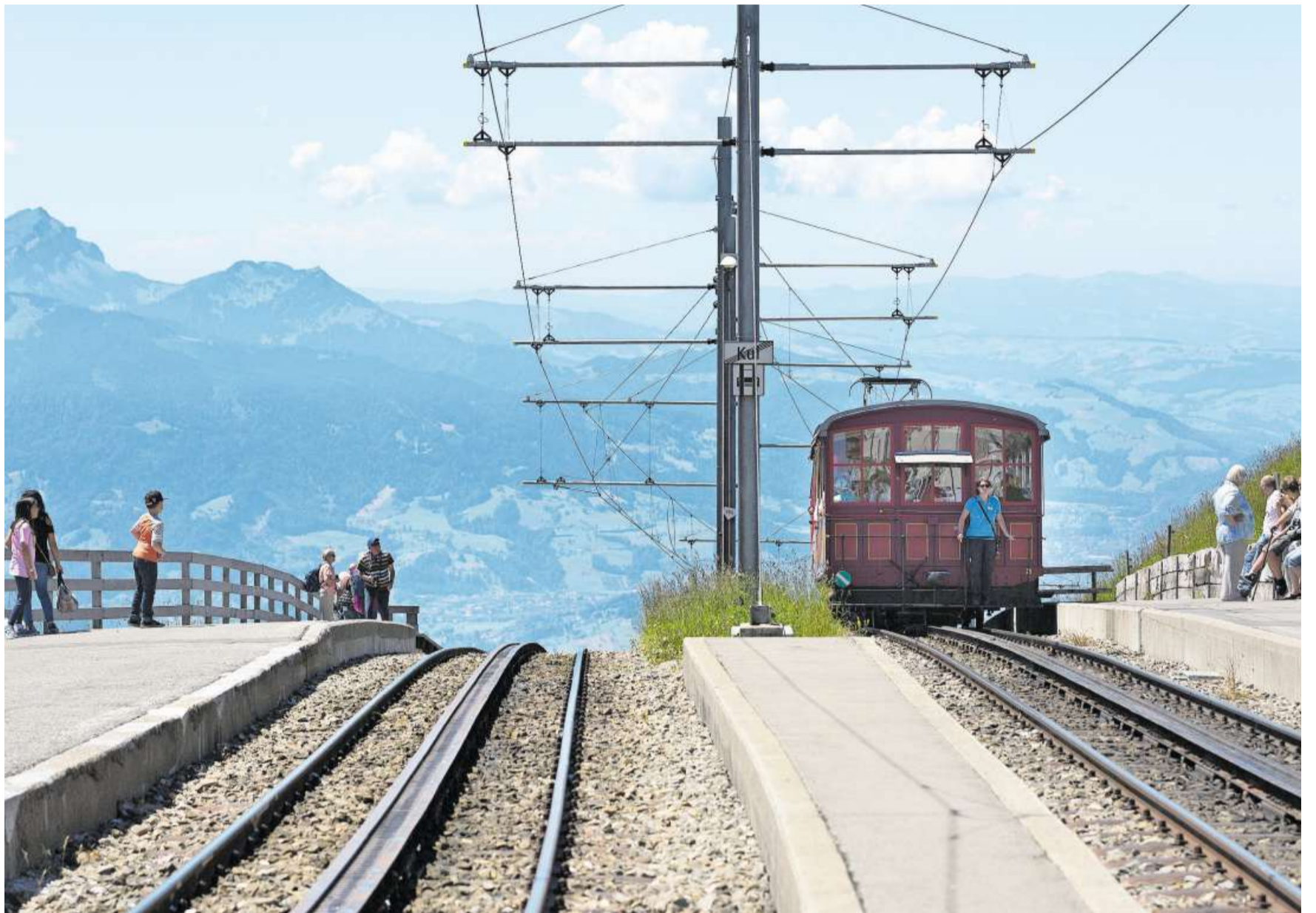
Entlang des Trassees der Rigi Bahn führen Wasserleitungen vom See bis nach Rigi Kulm.
