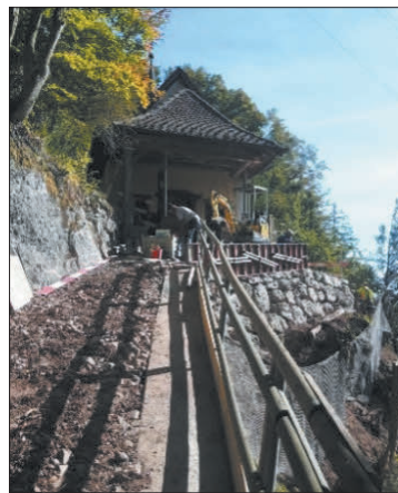
Sanierung Rigiweg bei Heiligkreuz Kapelle.
