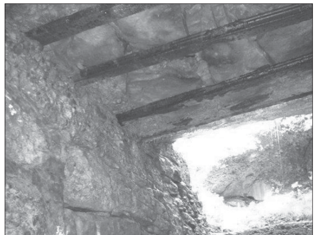
Verrostete Tragkonstruktion.
