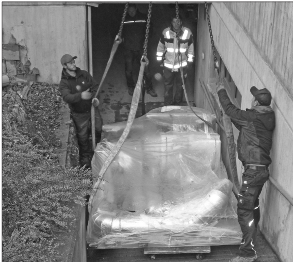
Wärmepumpe kommt in den Velokeller.
