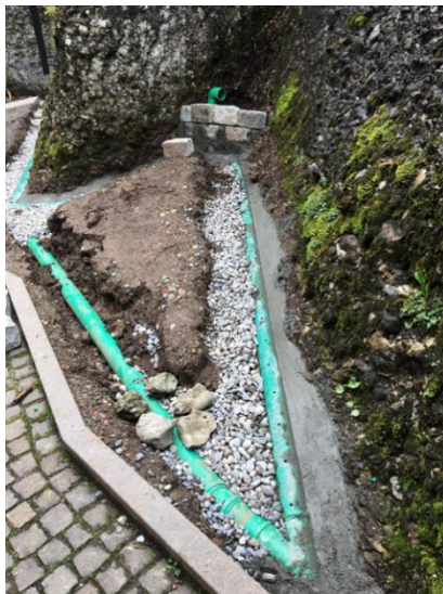
Entwässerung Felswände
