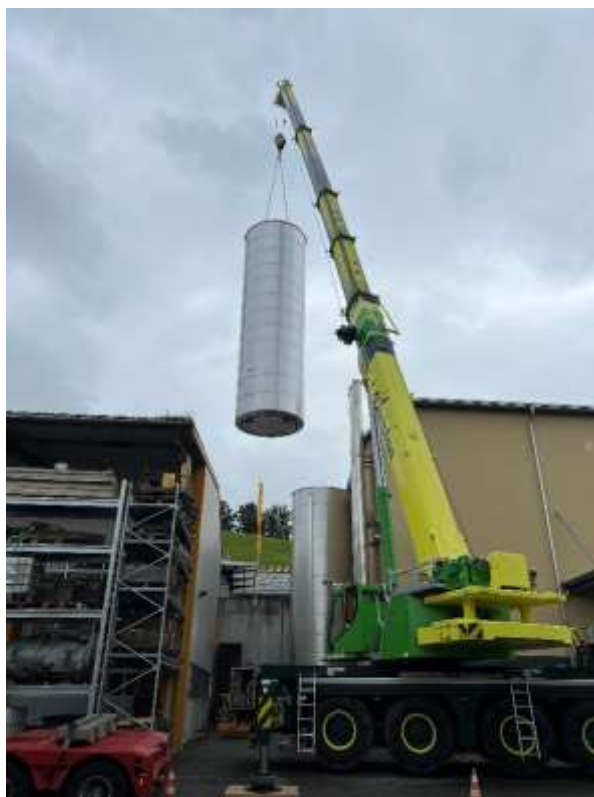
Installation der Gross-Speicher
