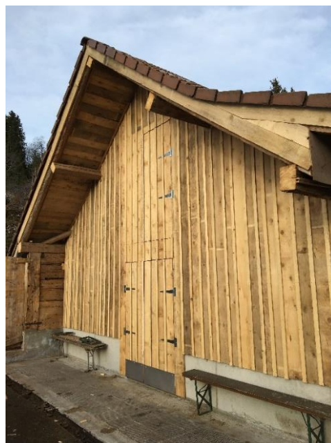
Remisen Anbau Untereggi Hütte
