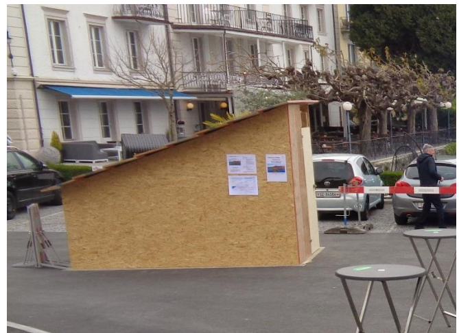
Prov. Einstieg ins Pumpwerk
