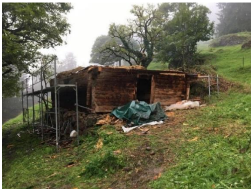
Abbruch Alphütte Obere Bueche
