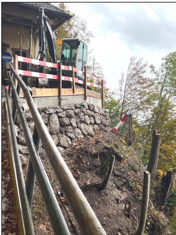
Sanierungsarbeiten am Rigiweg bei der Heiligkreuz Kapelle
