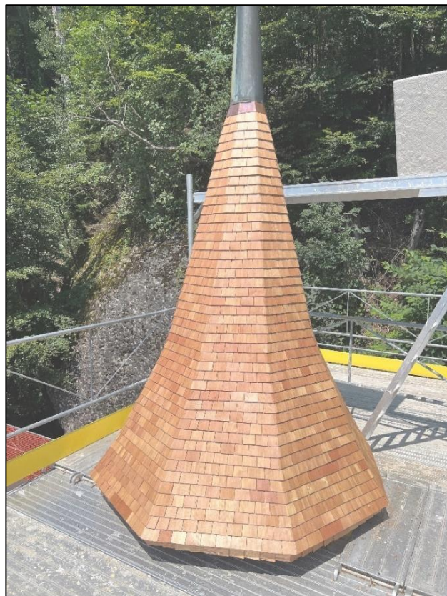
Glockenturm geschindelt nach Renovation
