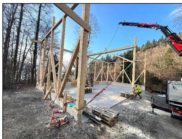
Bau Unterstand Energieholzlager, Lützelau
