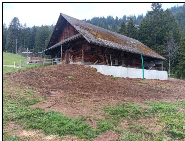
Alpstall Wichmatt nach Neubau Jauchegrube
